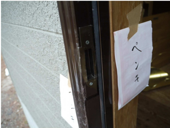
翌日の玄関鍵枠補修完成図
