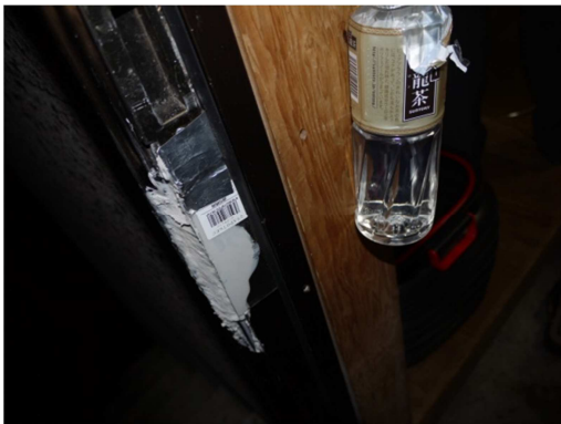
凹んだところをパテ埋めして凹みを目立たなくする
