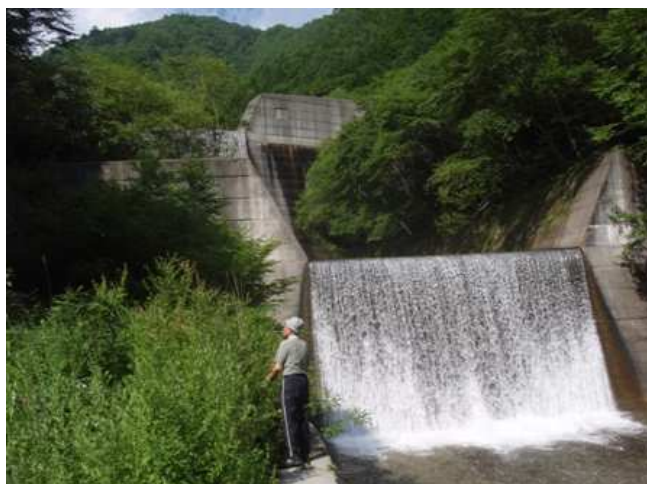
写真-3 蜂の巣小屋跡の上流の2段砂防ダム
