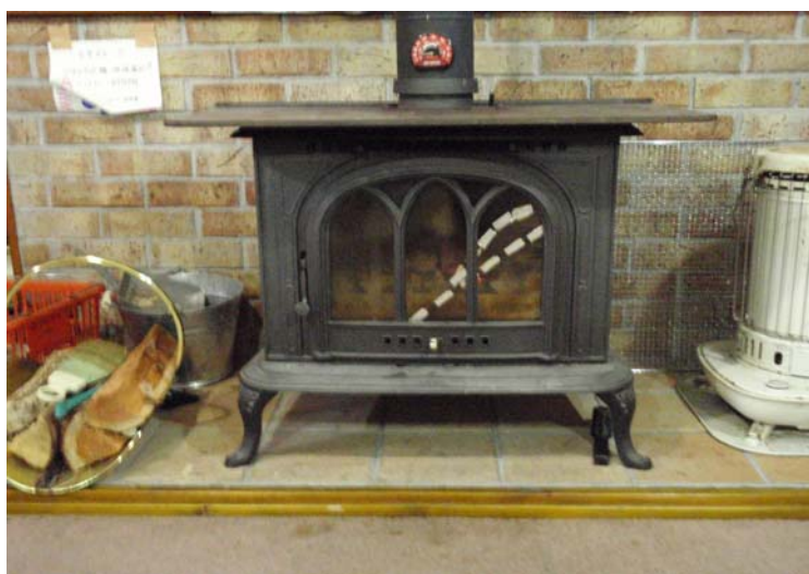
写真-10 ガラスを補修した薪ストーブ
