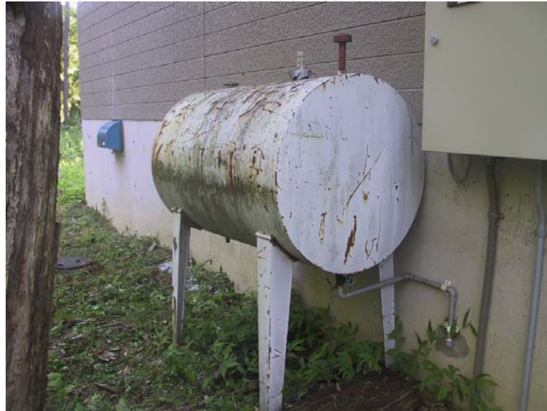
写真-5 屋外灯油タンク（500リットル用）
