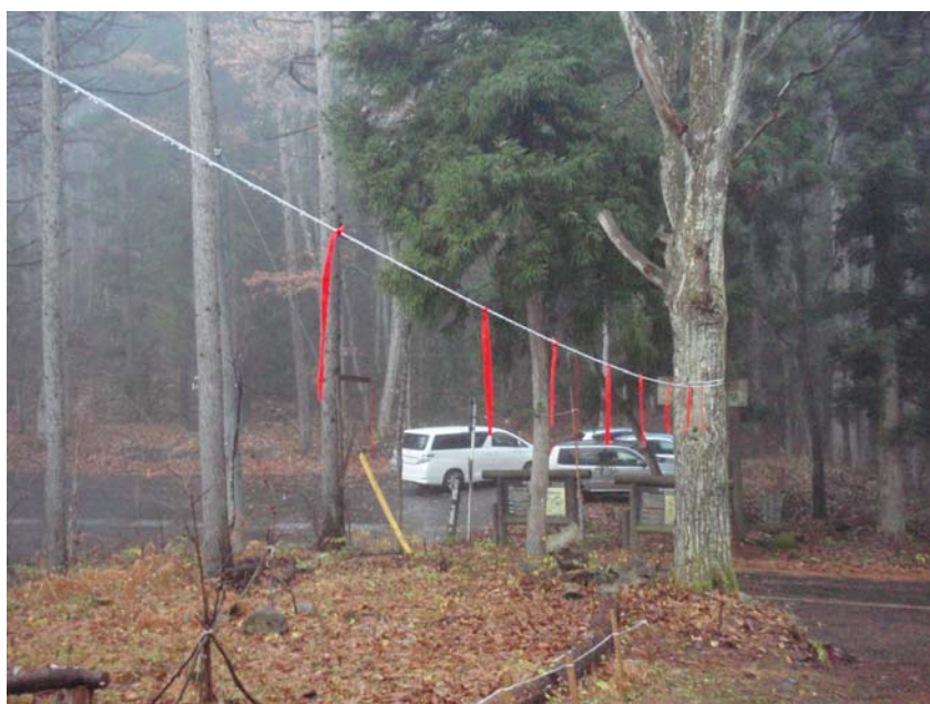
写真-8 除雪用赤旗の設置
