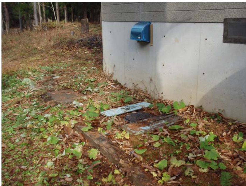
写真-7 排水ます、地下室換気扇、トイレ汲み取り口
