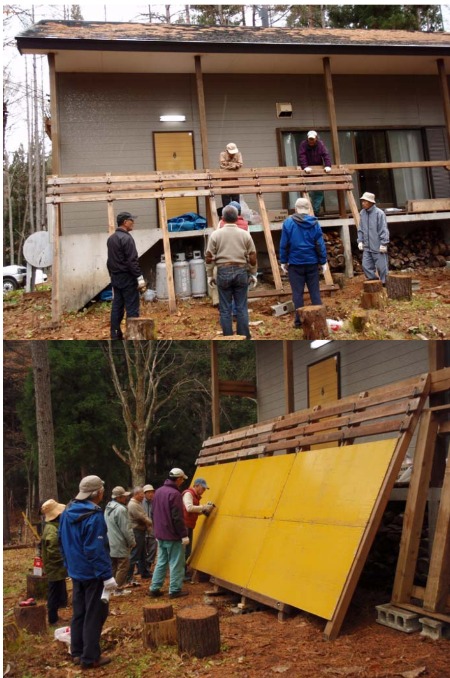
写真-4 雪防護柵の設置
