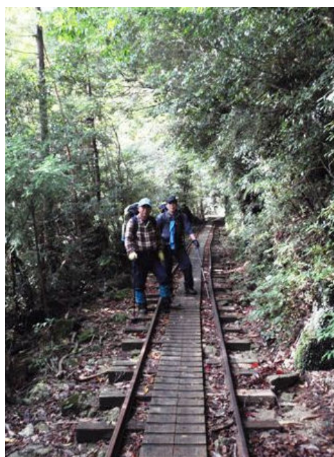
写真－12 トロッコ軌道
