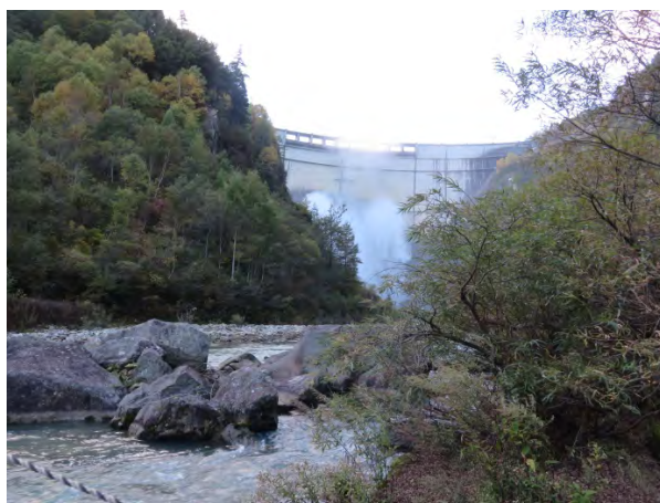
黒4ダムを見上げる
