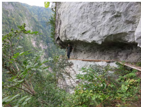
岩壁に掘られた道
