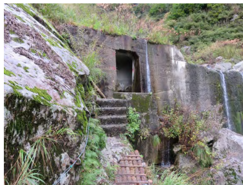
トンネルの入り口
