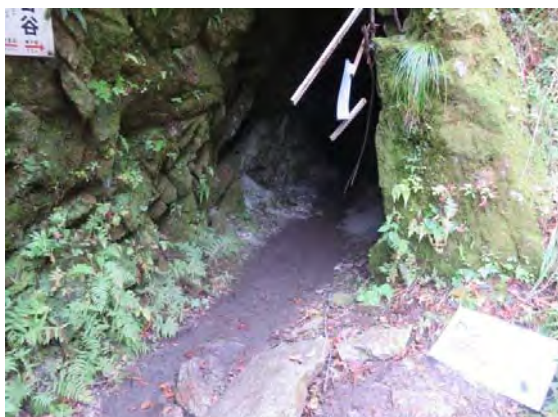
トンネルの入り口
