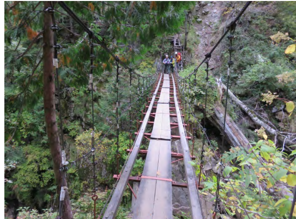
剣沢を跨ぐ吊り橋
