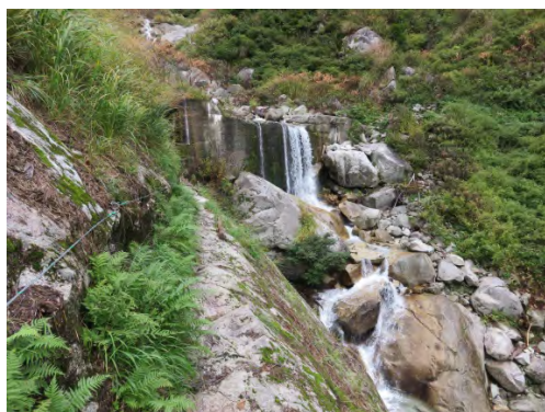
滝の下の堰堤
